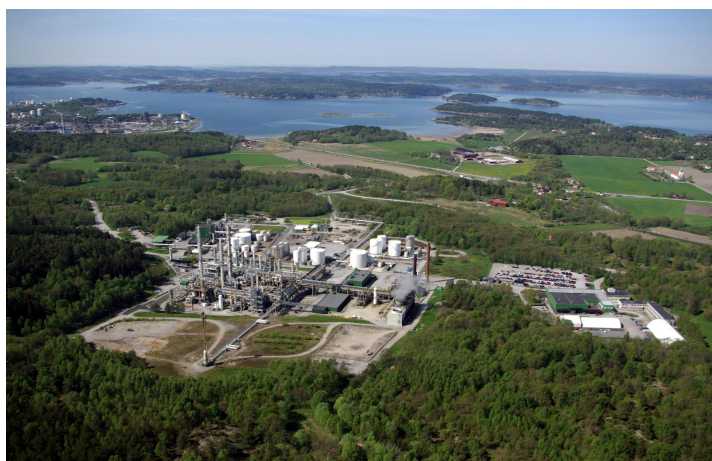
[Perstorps anläggning i Stenungsund]
